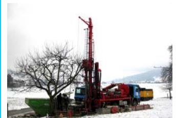
Erste Erkundungsbohrung östlich des Dorfkerns
