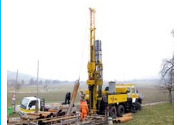
Kernbohrung bis auf den Molassefels in rund 100 m Tiefe
