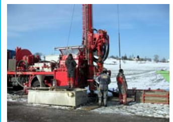
Zweite Erkundungsbohrung in der Talebene
