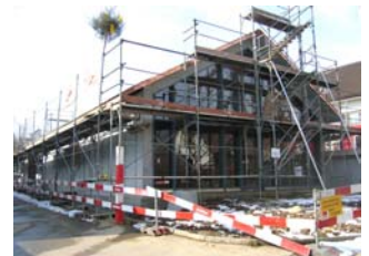
Rohbau des Museums Februar 2005
