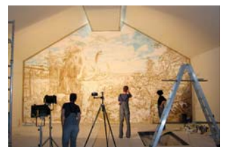
Das Wandbild entsteht durch die Equipe des Ateliers Bunter Hund
