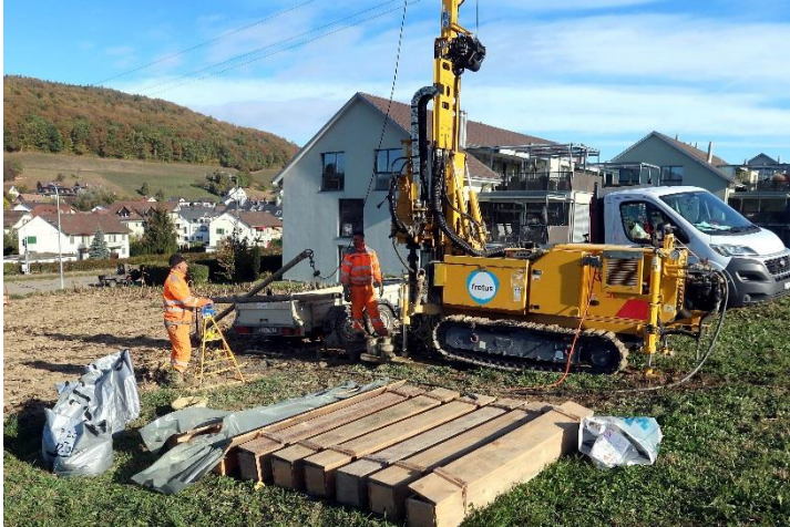
Kernbohrung an der Murzlenstrasse im Oktober 2018
