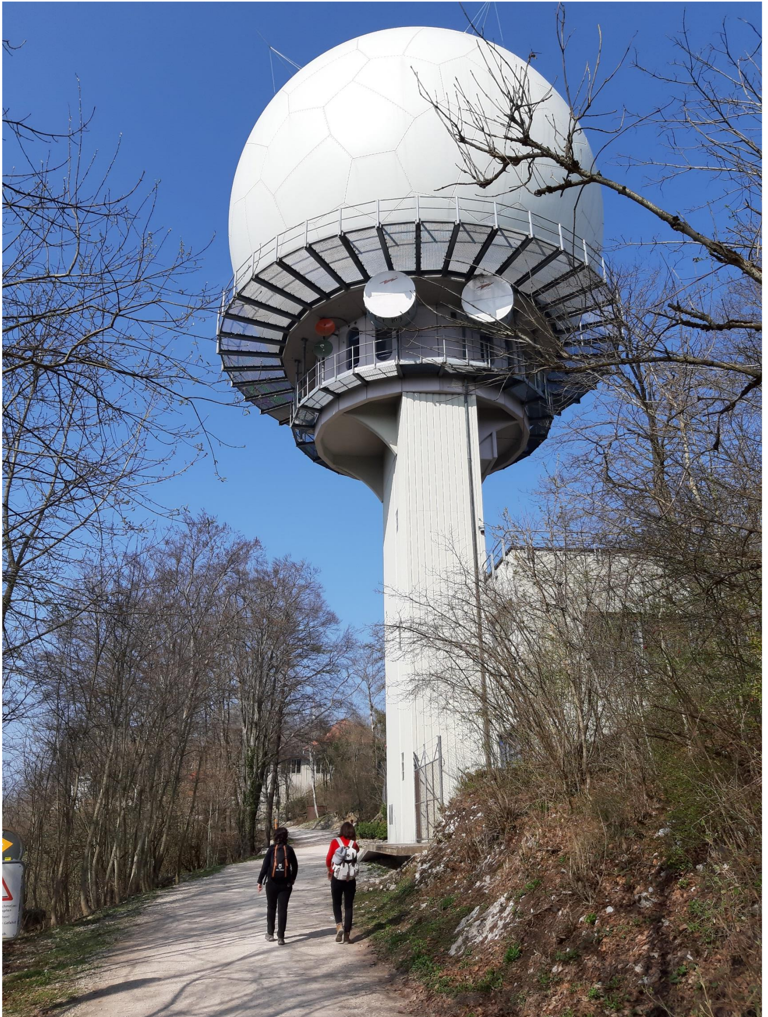
Skyguide Radaranlage Lägern Hochwacht
